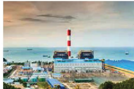
Vung Ang 1 Thermal Power Plant
